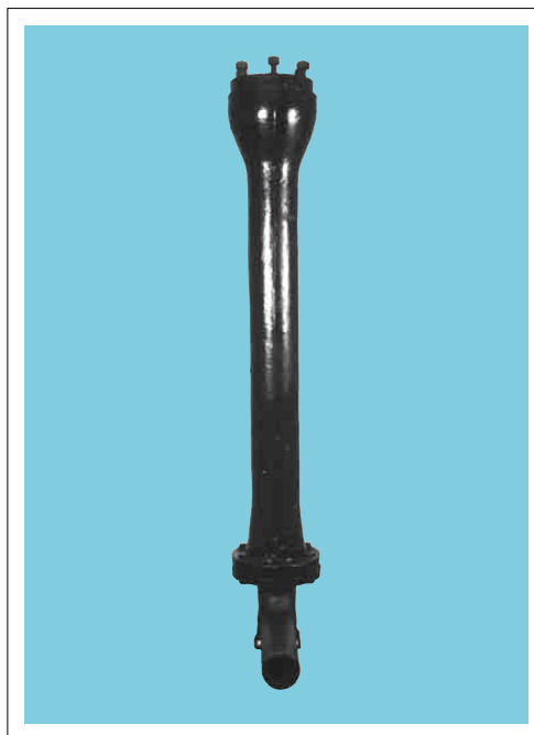
Unterteil zu Überflur-Hydrant Modell Clus 1896 / 1898 Gesellschaft der Ludwig von Roll'schen Eisenwerke Clus Unterflurteil zu Hydrant Nr. 23. Eigenart dieses Modells, die Entwässerung erfolgt in der Fussmitte des Einlaufbogens Von W. Gerhard, Brunnenmeister, Windisch – Brugg / AG
