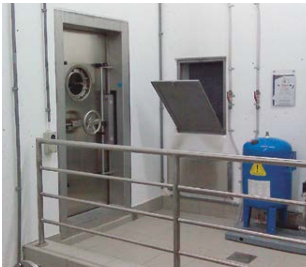
Bild 6 und 7 Räume mit erhöhten Radonkonzentrationen werden luftdicht verschlossen.
