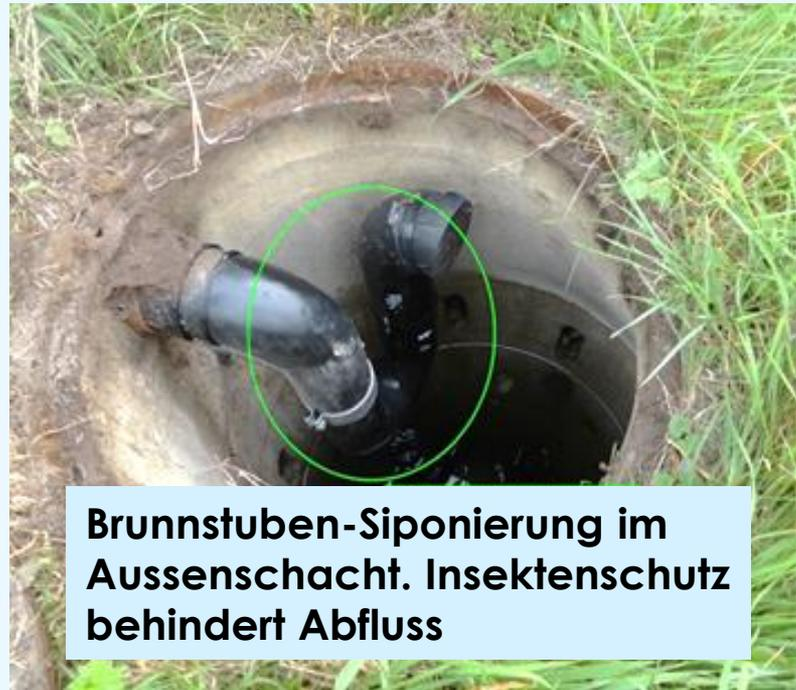
Brunnstuben-Siponierung im Aussenschacht. Insektenschutz behindert Abfluss
