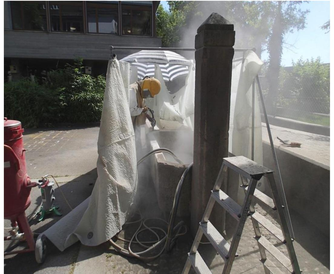
Sablage des faces visibles à basse pression max. 1 bar.
