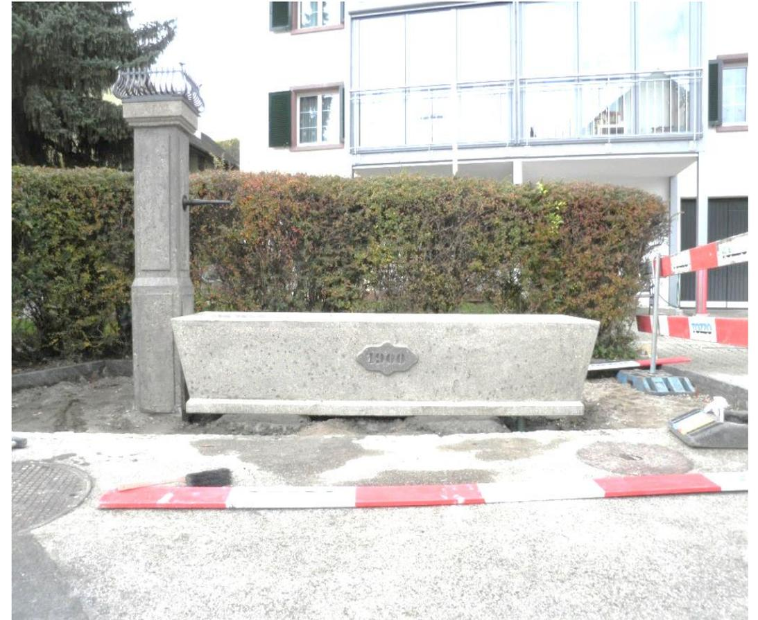
Fontaine recrée à neuf, sans armature en fer, remplacée par des fibres synthétiques.
