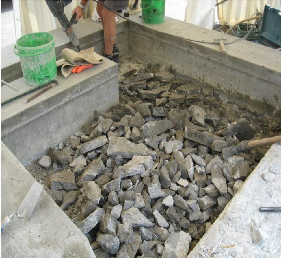
Le fond et les parois du bassin sont piqués mécaniquement. Plusieurs joints de mortier sont éliminés.
