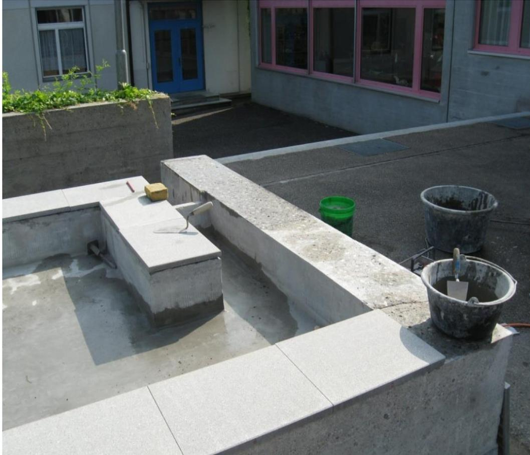
Bordure exécutée avec des dalles en béton.
