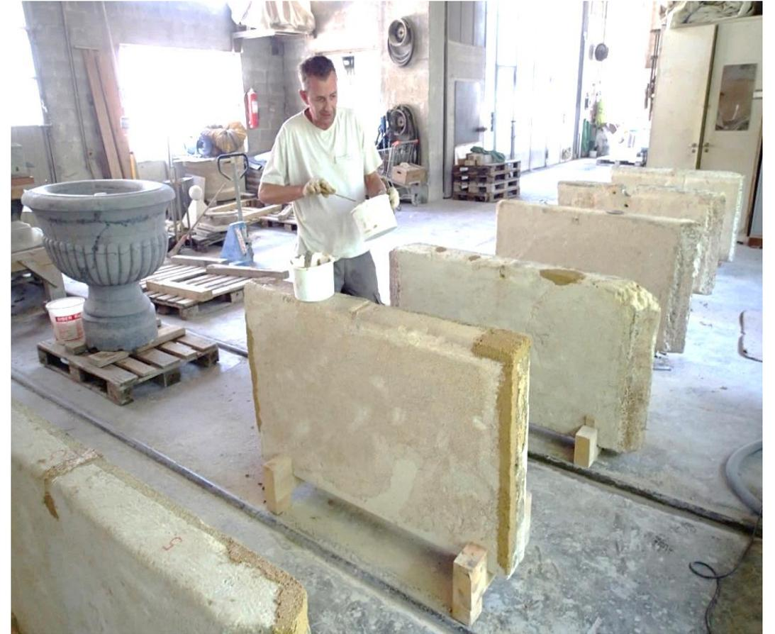
Flancs rénovés, colmatage des fentes par injection, reprofilage.
