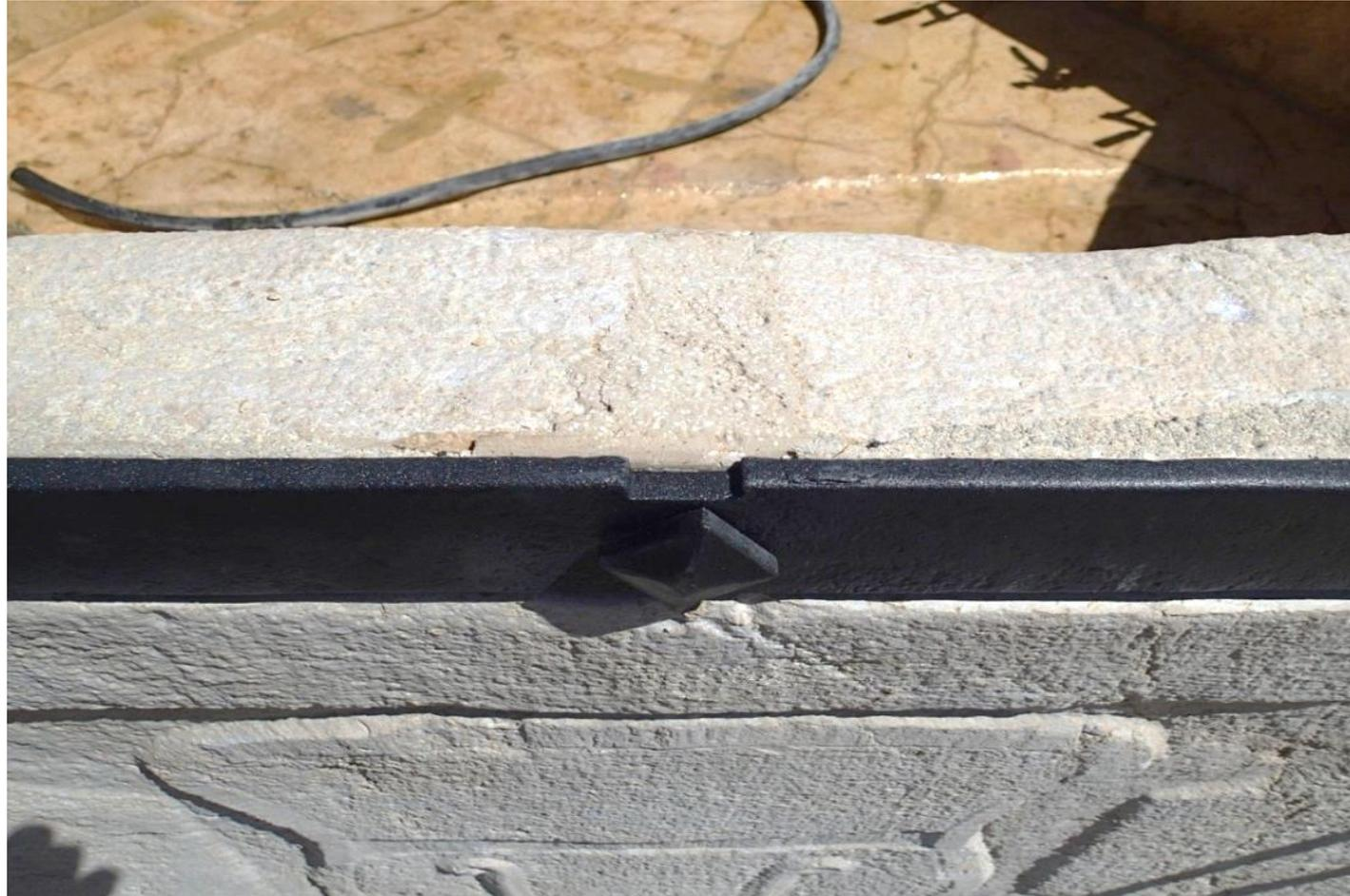
Fixations au même endroit comme d'origine. Remplissage au plomb fondu pour éviter les dégâts à la pierre. Réparation des endroits détériorés par la rouille.
