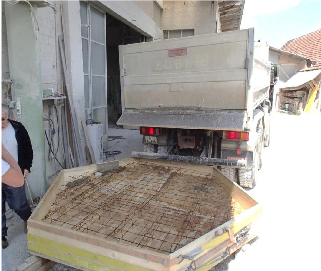
Fond retourné à l'envers, renforcement par fondation en béton armé. Livraison du béton, remplissage et vibration.
