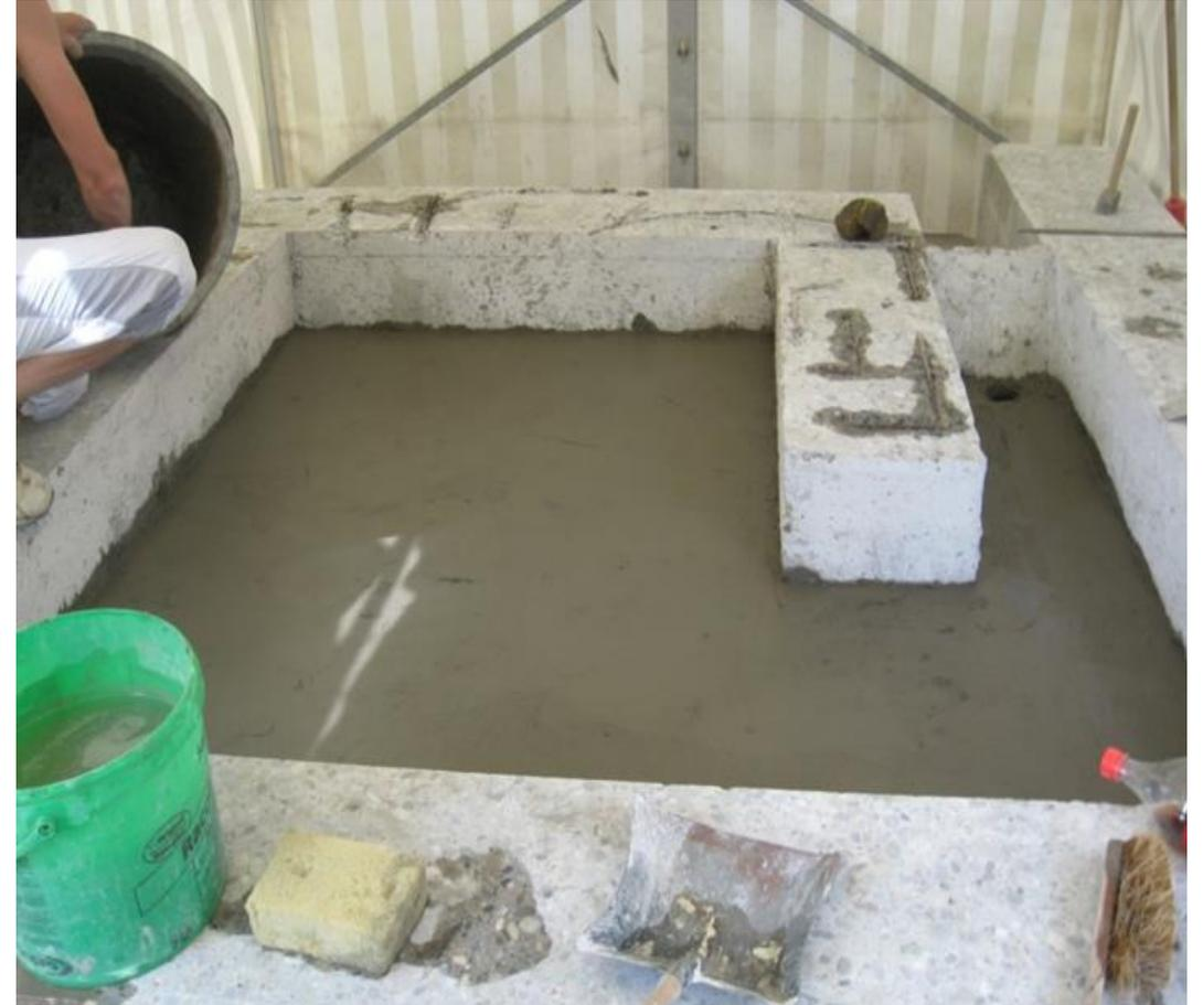
Le fond est égalisé et reprofilé avec une pente afin que l'eau puisse s'écouler correctement.
