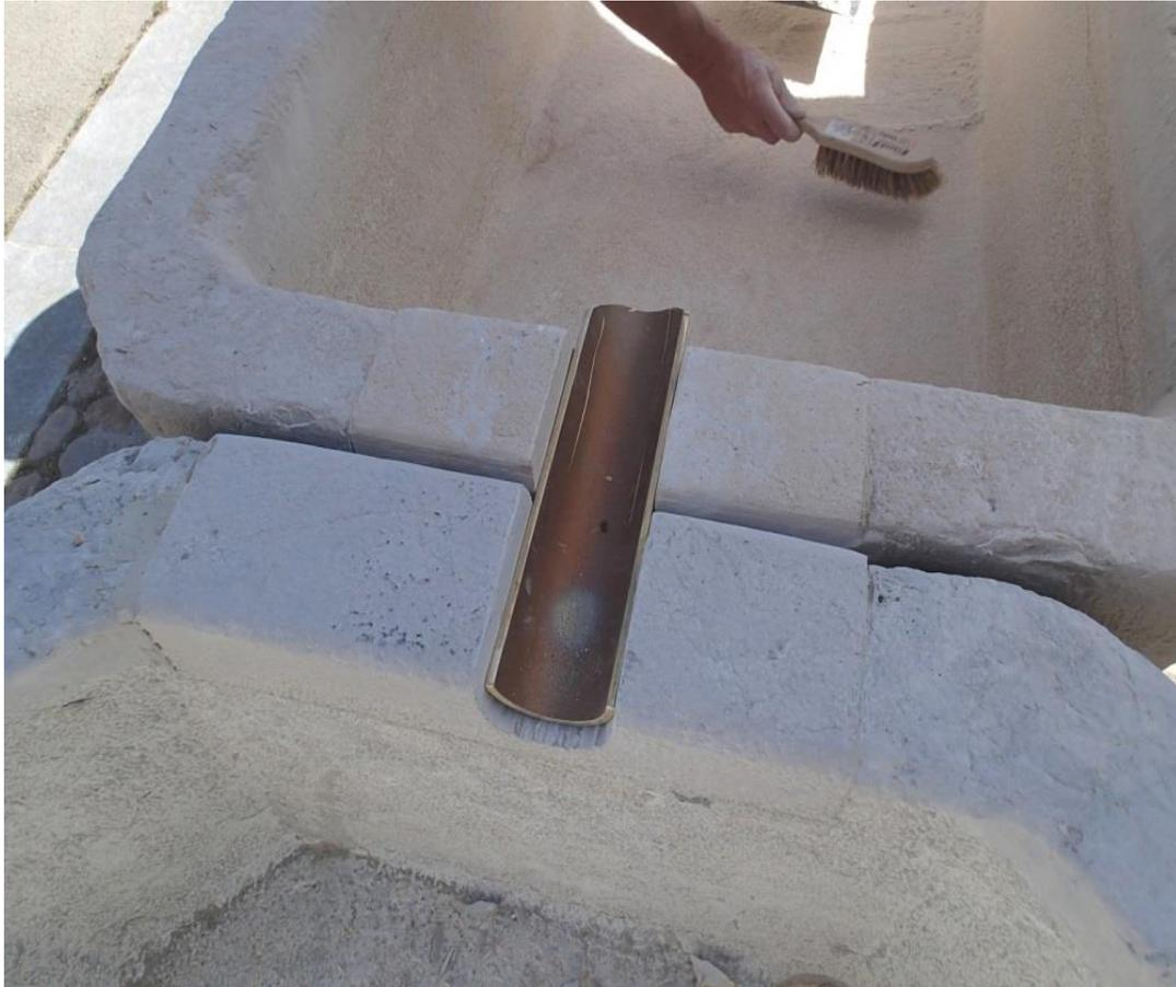
Nouvelle rigole de trop-plein en laiton collée avec une résine époxy.
