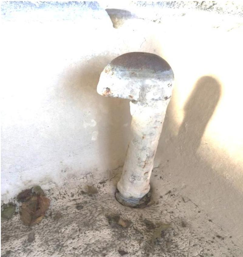
(Möhlin/AG): écoulement rouillé et calcifié
