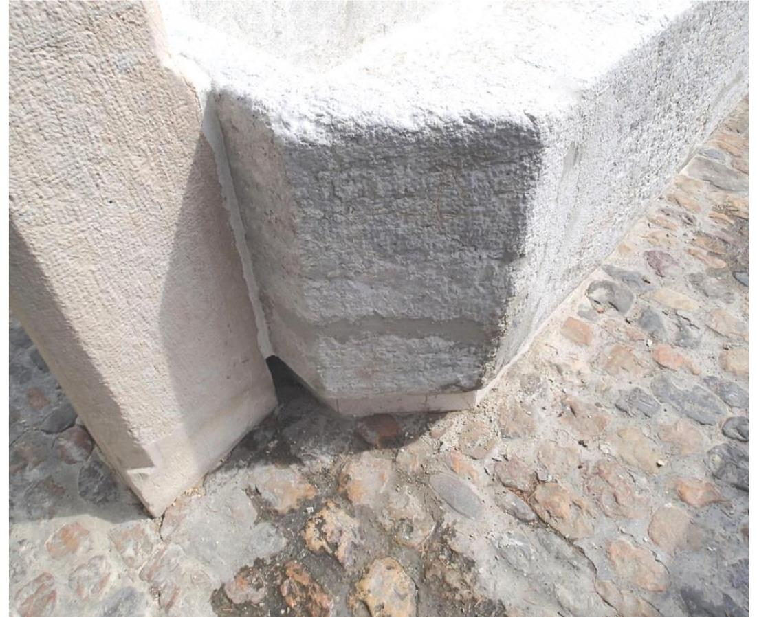
Fissure réparée avec du mortier à base de pierre naturelle. Ajustement de la teinte.
