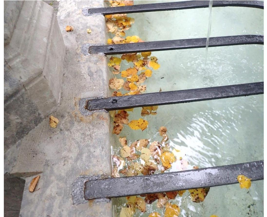
Façonnage des évidements dans la pierre. Pose de la grille décapée, remplissage à l'argile pour éviter que le plomb fondu ne déborde sur la pierre.
