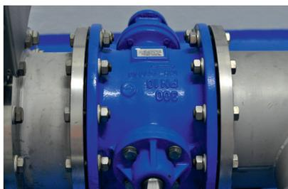
Armature de fonte séparée par une douille isolante
