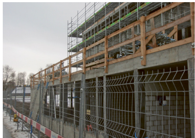
1 Korrekter dreiteiliger Seitenschutz gemäss SN EN 13374
