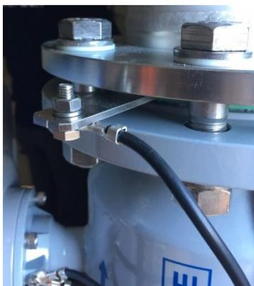
Abbildung: Korrekter Anschluss des Erdrings
