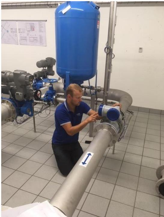
Abbildung: Parametrierung eines MIDs für beidseitigen Durchfluss
