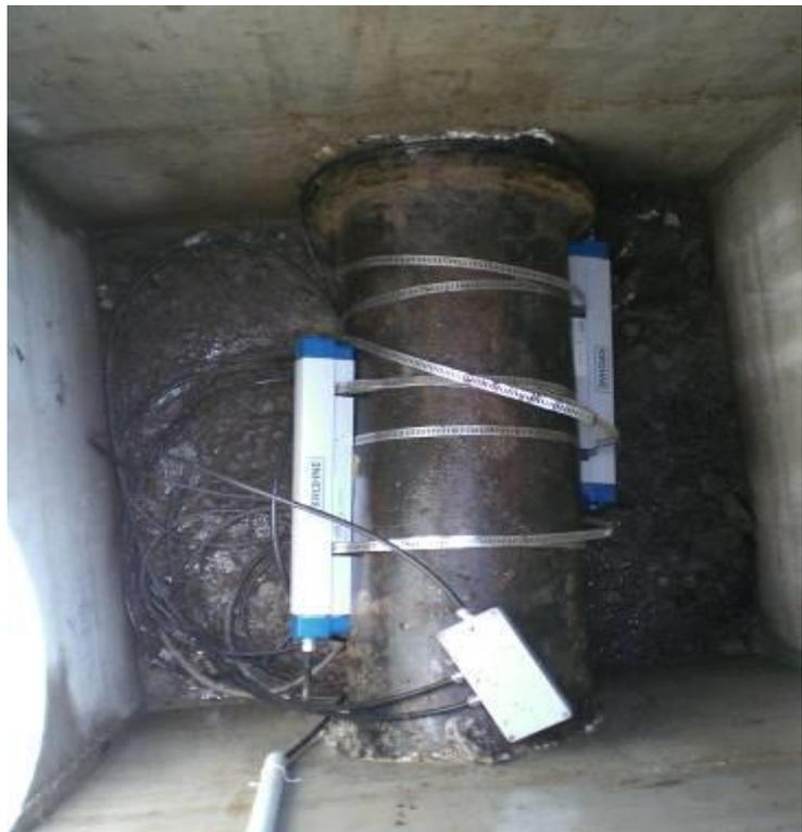
Abbildungen: Ultraschallmessungen an die Rohrleitungen aufgeschnallt
